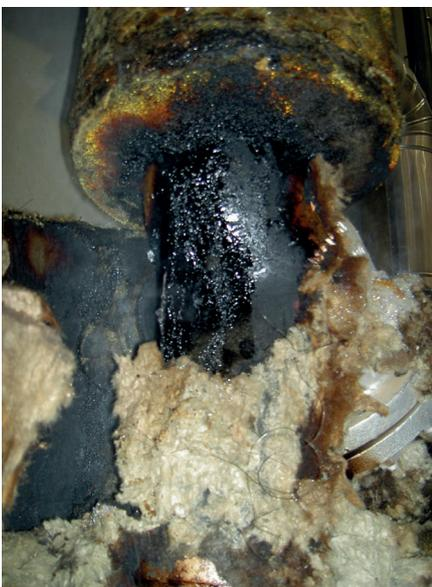
*Brandgefährdung durch in die Isolierung eingedrungenes Wärmeträgeröl – Vermeidung durch vorbeugende Wartung und Inspektion.*
